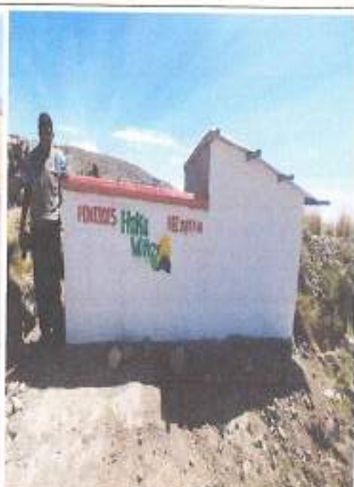
IMPLEMENTACIÓN DE MÓDULO DE PORCINOS EN EL NEC ZEPITA II
