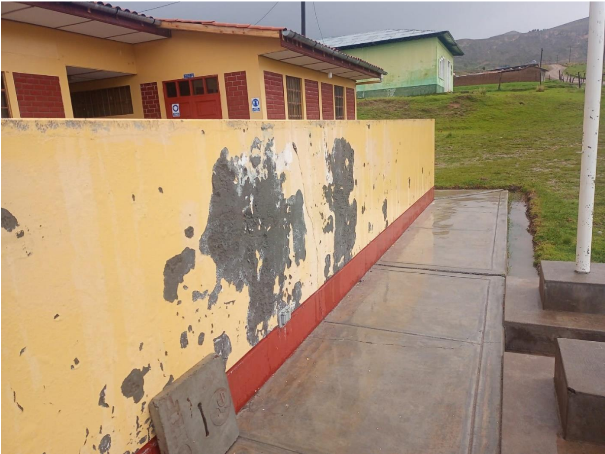
2.-Cuatro (04) fotografías de las paredes exteriores del Tambo
