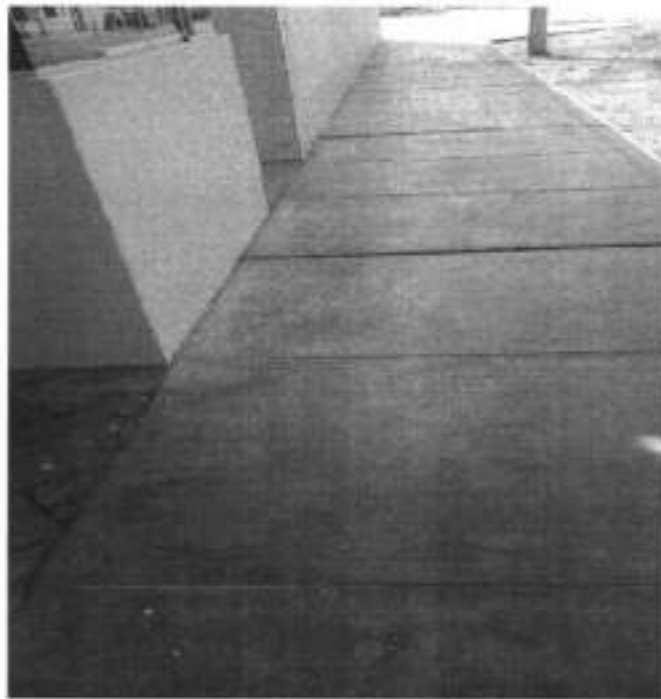
Foto 01: Ingreso al CIAI sin ningún tipo de señalización en el piso.
