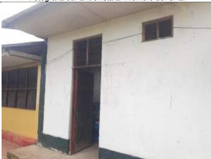
Fotografia 02: verificacion de ambiente de almacen de productos.
