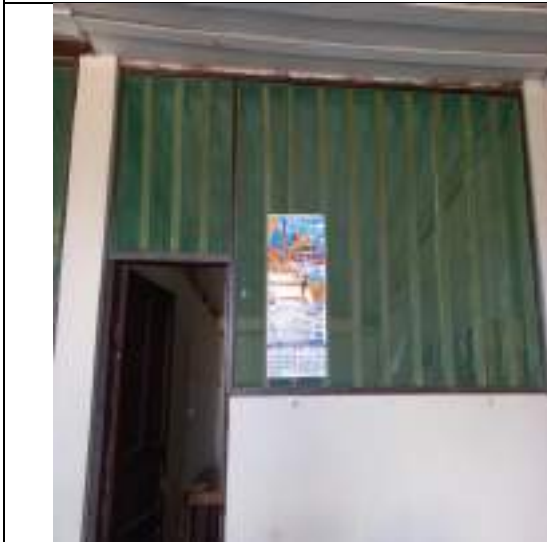
FOTOGRAFIA 01: Almacén de los alimentos con las medidas preventivas de protección en las ventanas
