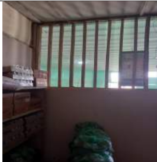
FOTOGRAFIA 01: Almacén de los alimentos con las medidas preventivas de protección en las ventanas
