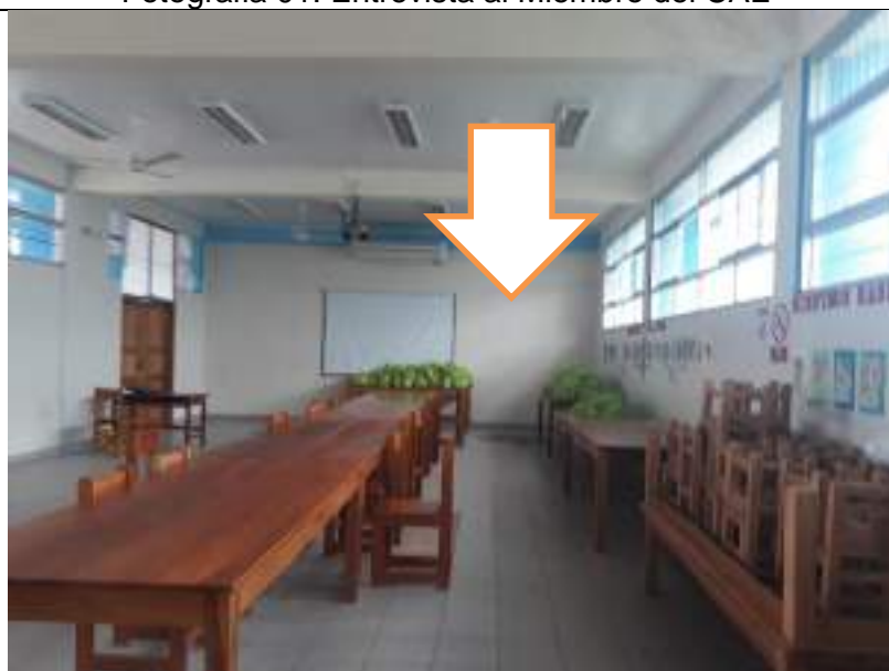
Fotografía 02: Verificación de almacén de I.E.
