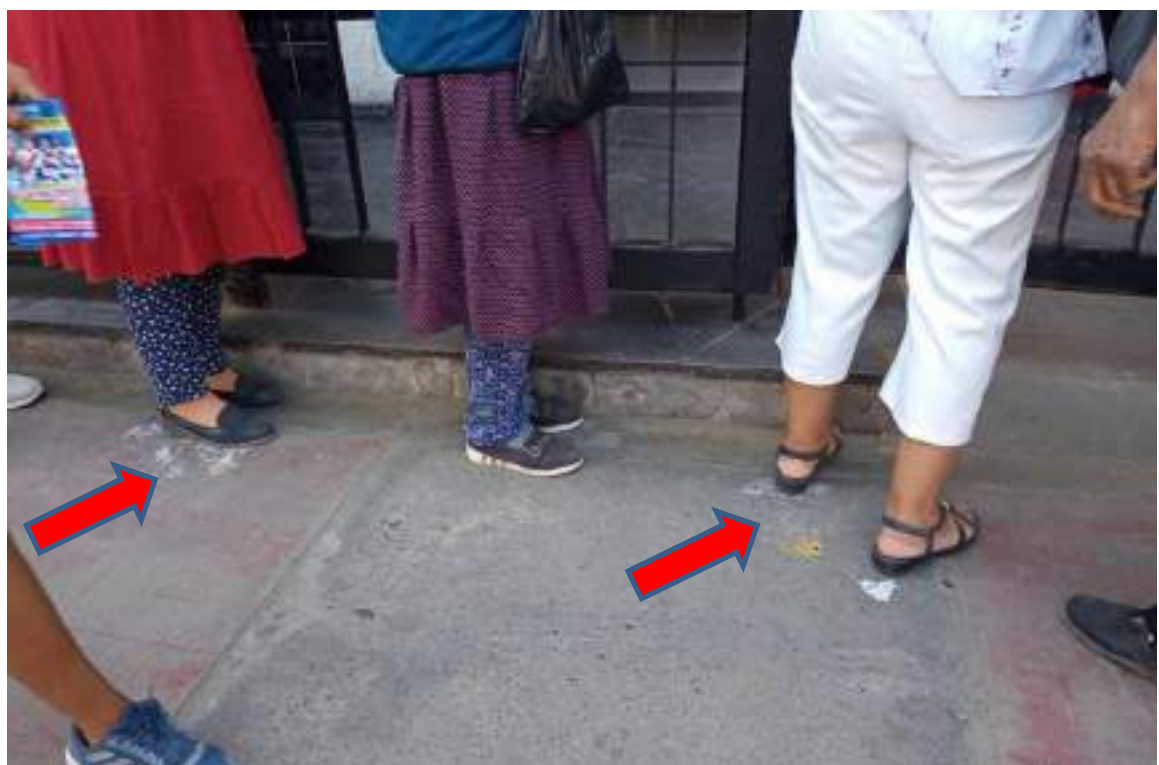
Señalizaciones del distanciamiento en el piso desgastada
