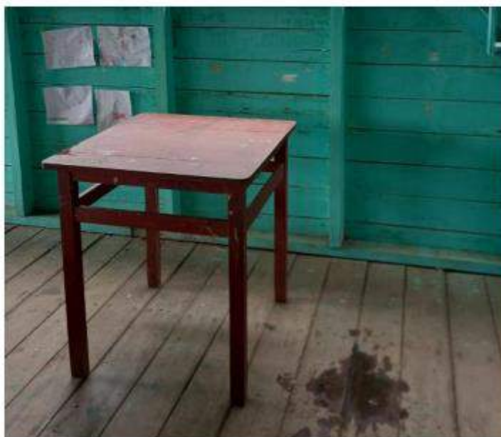
Imagen N°01. Evidencia fotográfica del ambiente de almacenamiento
