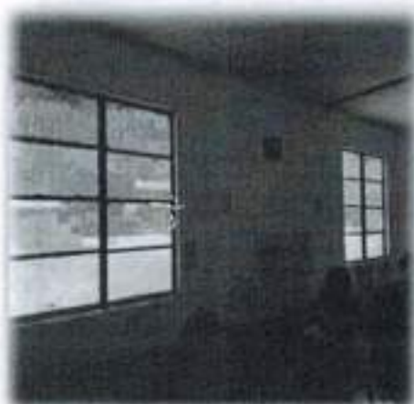
VENTANAS DEL COMEDOR INSTALADAS
