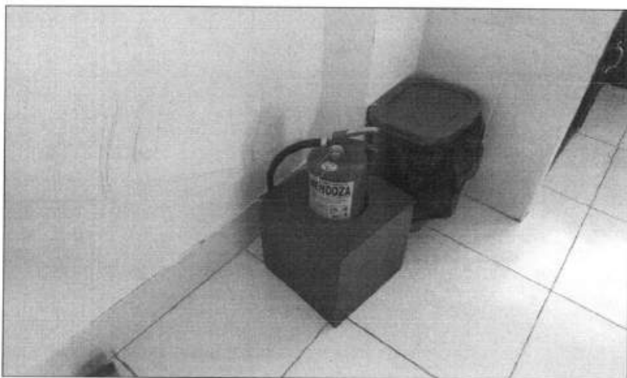
Foto 02: En la visita al CIAI "Rayitos de Sol" del distrito de Nuevo Chimbote se observa el extintor ubicado en el suelo.
