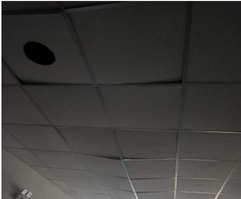
ANEXO 04 TECHO DEL CIAI RAYITOS DEL SOL.
