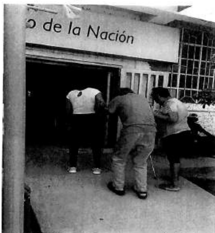
Rampas sin barandas y usuarios expuestos al sol
