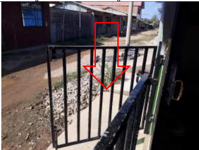
Fotografia 02: Ingreso a CIAI, salida de agua domestica y servida de la casa contigua.
