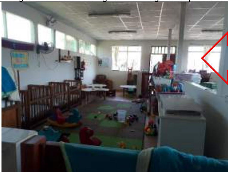
Fotografía 02: No se aprecia ningun tipo de señalizacion.
