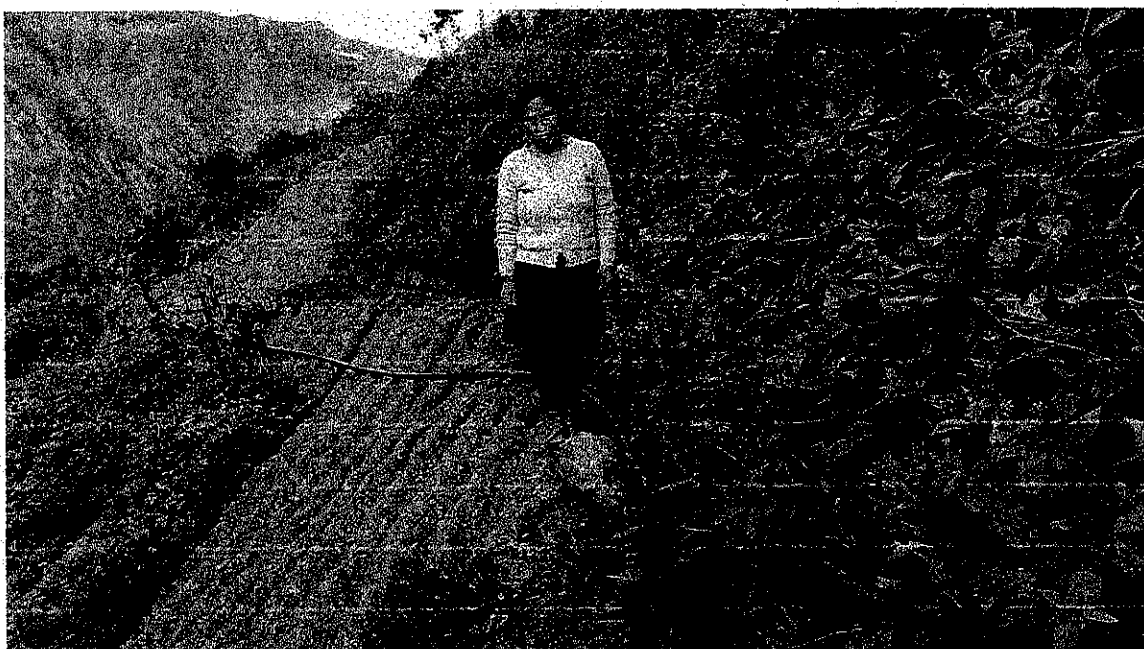
FOTOGRAFIA No. 01.- En la vista se puede observar a la Sra. Yoselin Delicia Ramírez Vergara, mostrando la instalación de su sistema de riego tecnificado por aspersión.
