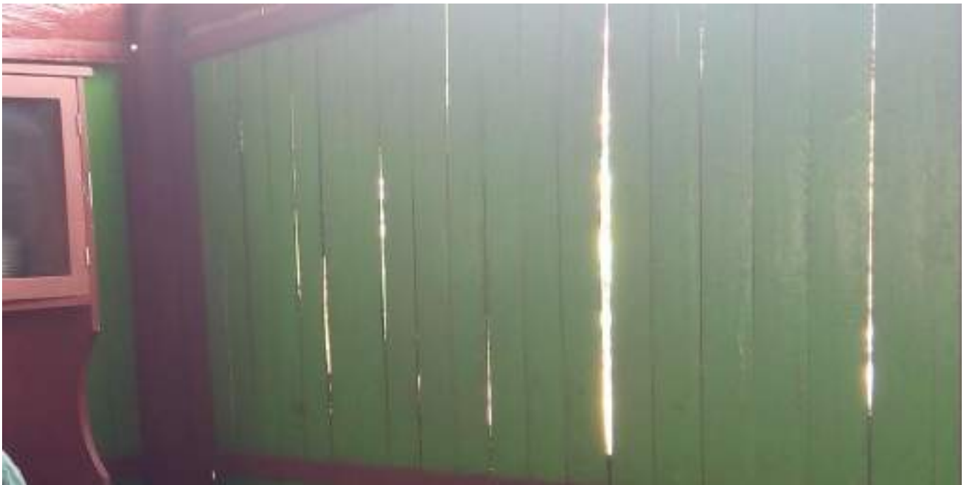
Aberturas en la pared de la cocina.
