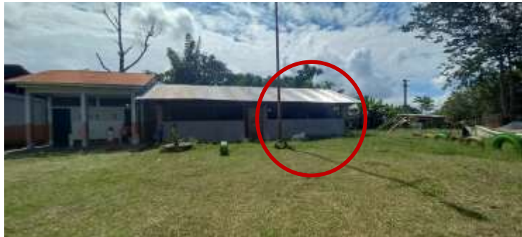
Fig. N° 09 ambiente en donde se puede trasladar hasta que culmine con las refacciones
