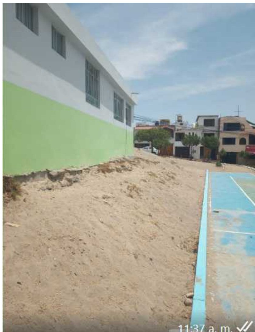
ANEXO N°04: Imagen de condiciones de infraestructura del CIAI
