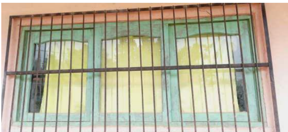
Ventana 1 exterior protegido con estructura de fierro
