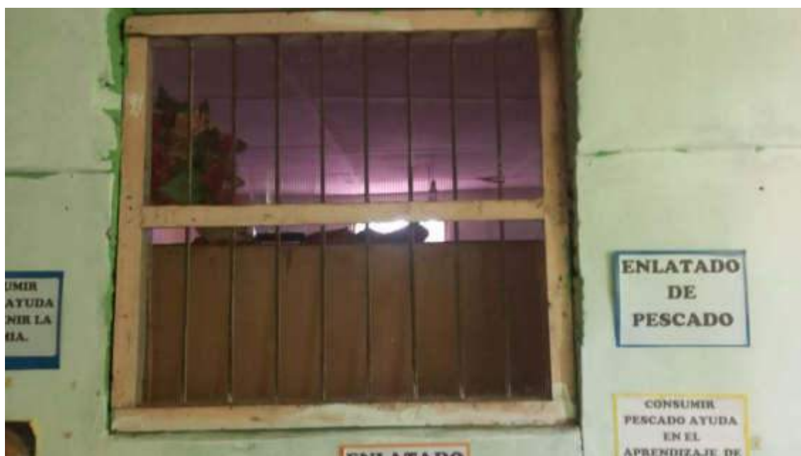
Ventana 2 interior del almacén – Protegida con malla y fierros (colinda con la dirección de la IE)
