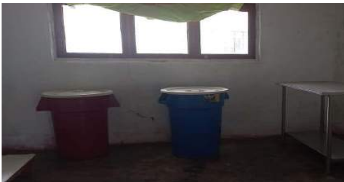
Ventana 1 interior del almacén – Madera y vidrio
