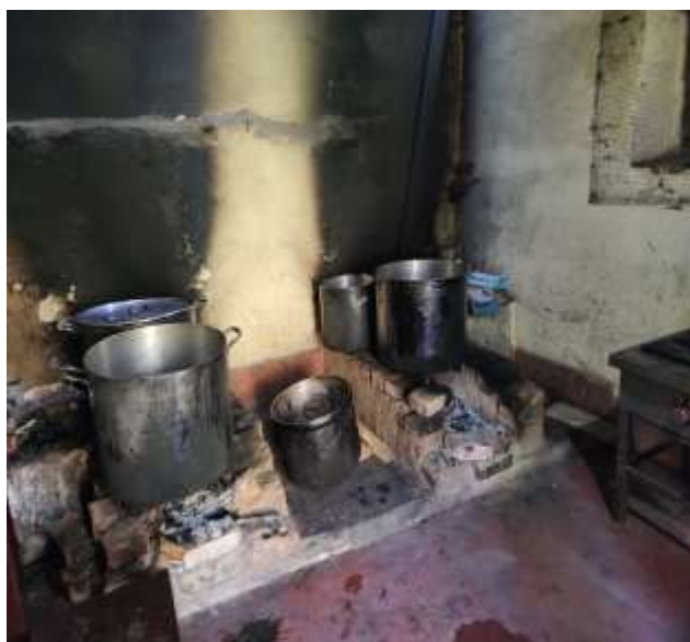
Fotografía 03: vicharra de la cocina (antes de la refacción)
