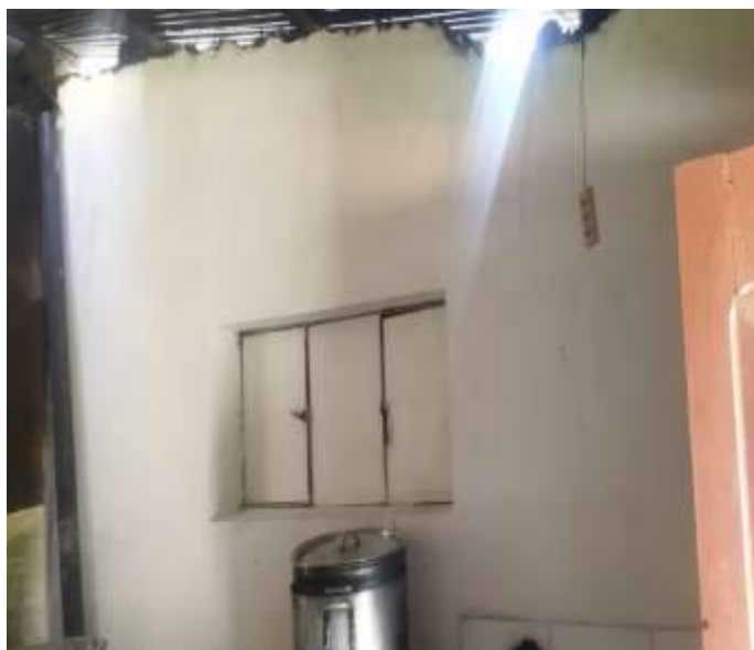
Fotografía 02: Fachada de la cocina (después de la refacción)
