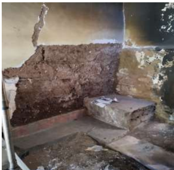
Fotografía 01: Fachada de la cocina (antes de la refacción)
