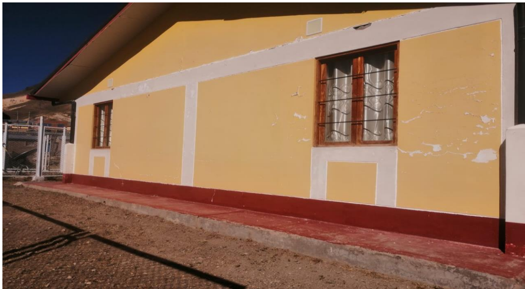
Figura 10: Vista lateral derecha del Tambo Juncal
