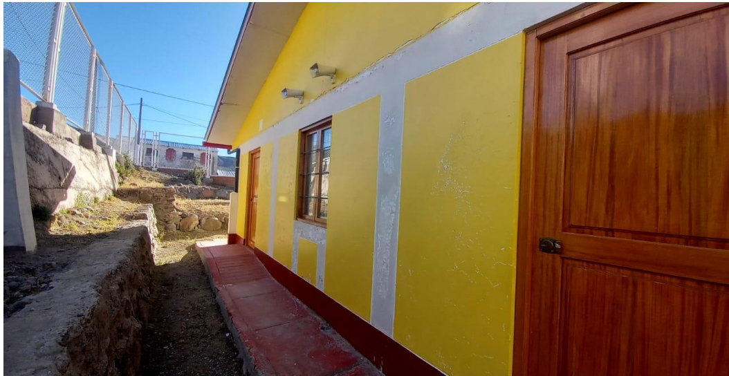
Figura 10: Vista lateral izquierdo del Tambo Juncal
