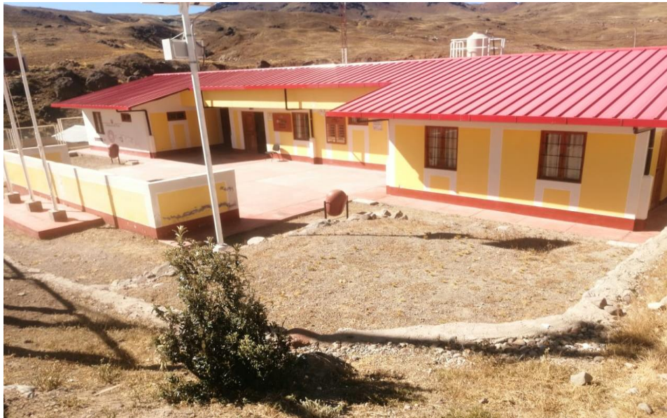
Figura 8: Vista frontal del Tambo Juncal
