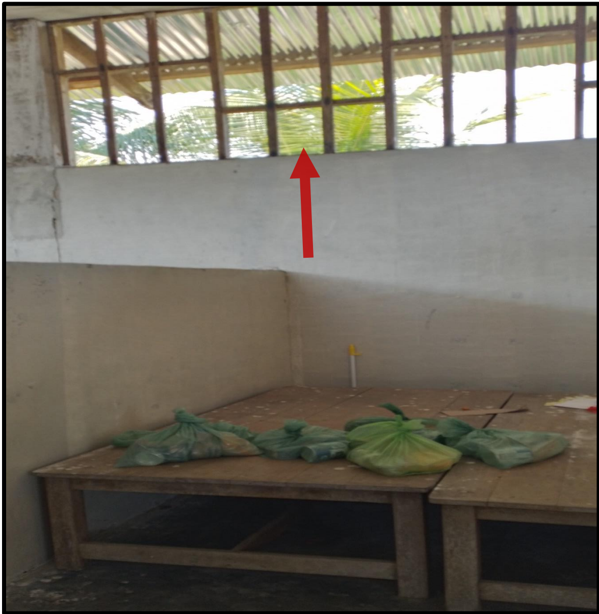
Anexo N° 04: Fotografía del ambiente en el cual se almacenan los productos.
