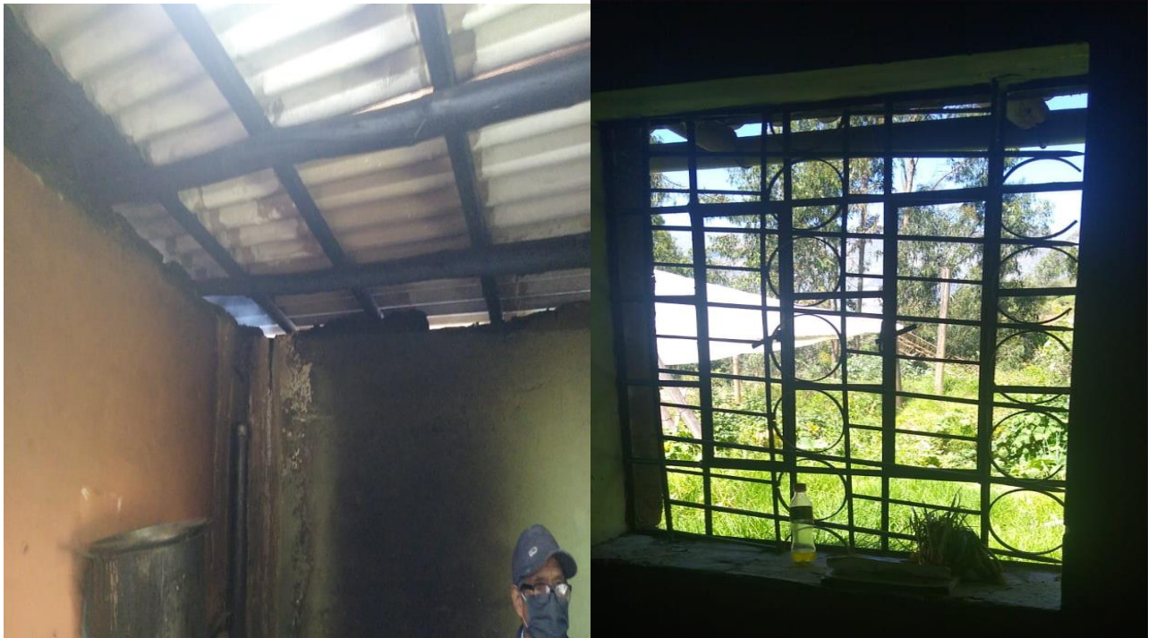
Foto 02: Lugar de preparación de los alimentos, con ventanas abierta y techo con aberturas.
