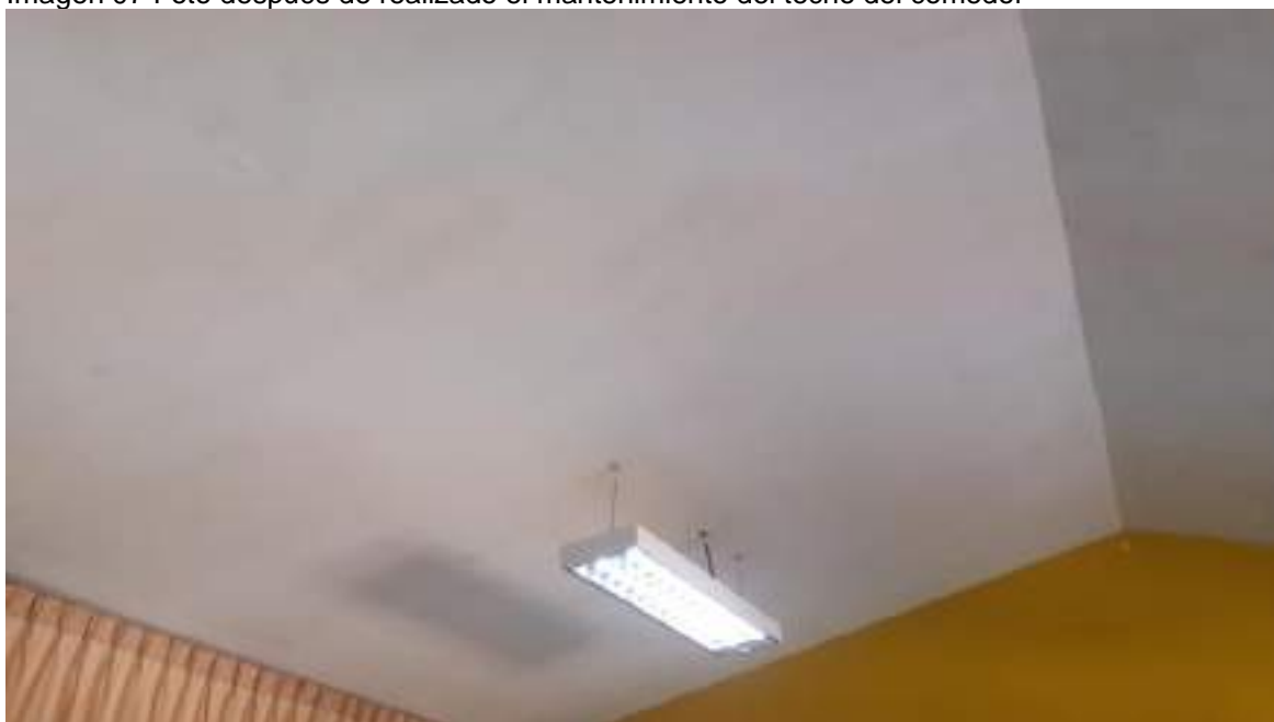
Imagen 07 Foto después de realizado el mantenimiento del techo del comedor
