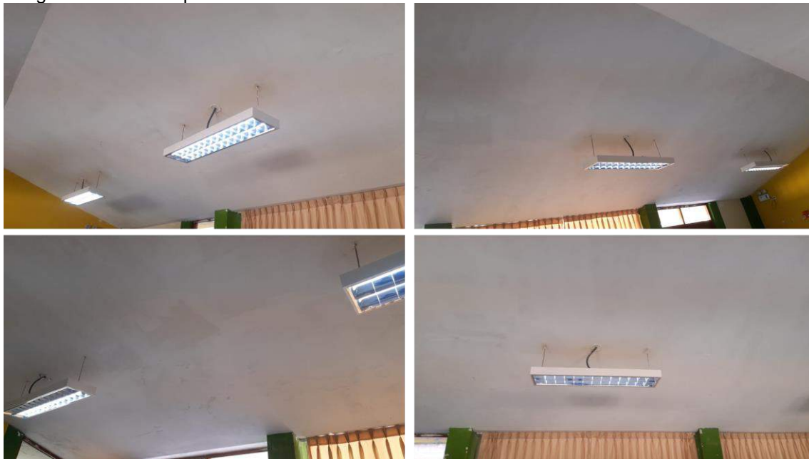
Imagen 06 Fotos después de realizado el mantenimiento del techo del comedor
