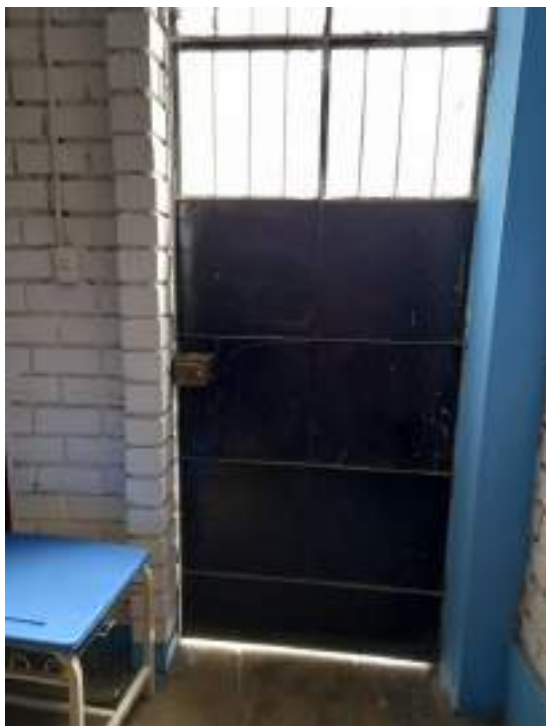
Fotos del acondicionamiento del almacén
