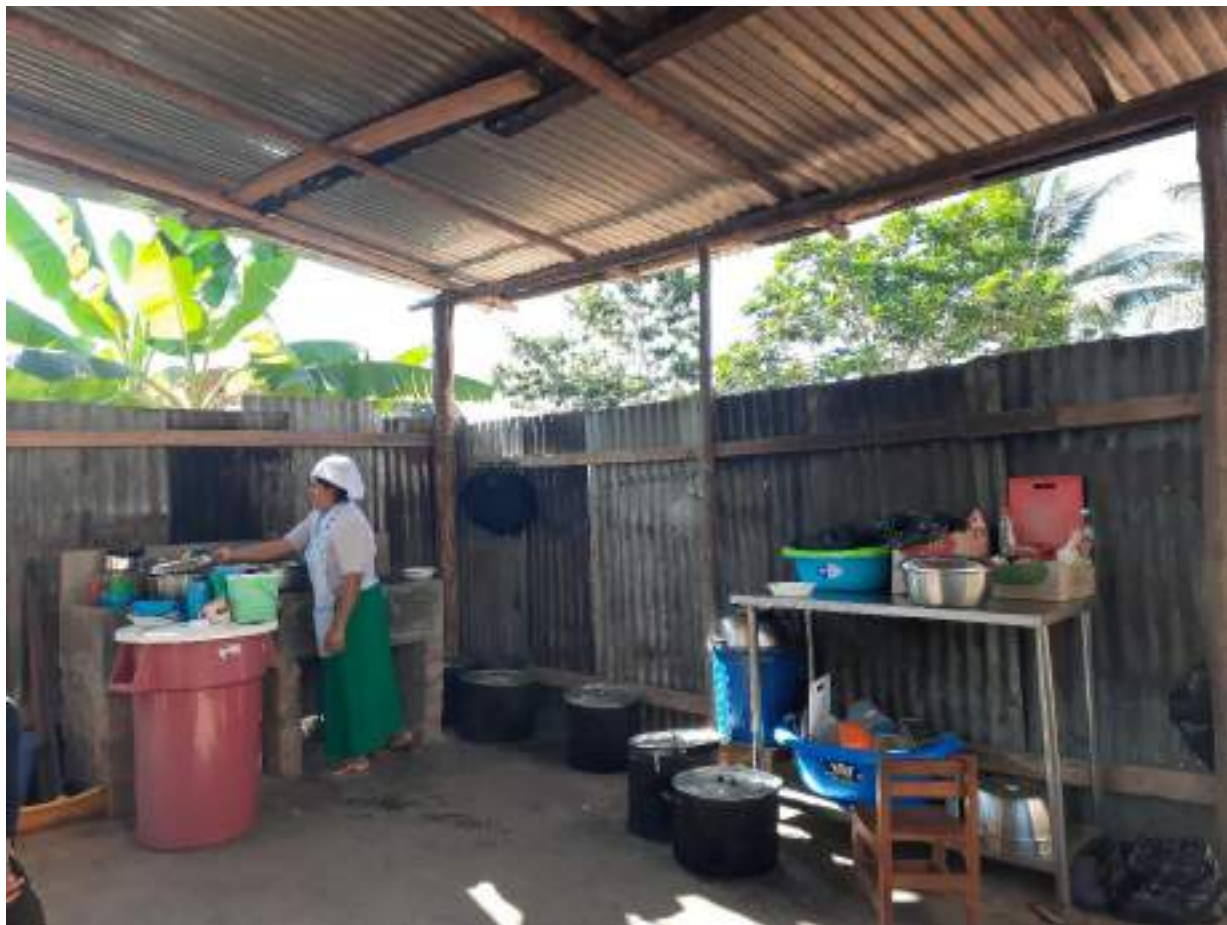
Anexo N° 02 Vista de espacio de preparado de los alimentos, donde se aprecia que no tiene ninguna protección contra el ingreso de animales, roedores e insectos, ya que está expuesto al medio ambiente.
