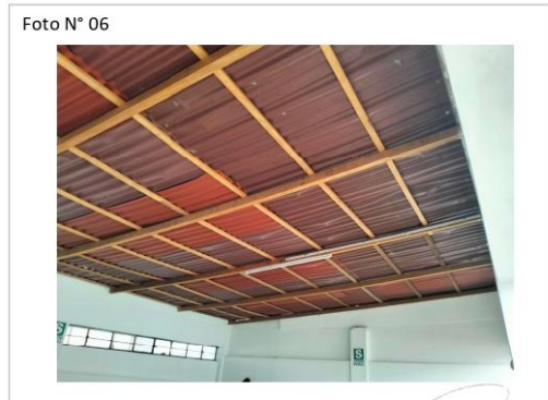
Vista de la cobertura con orificios y estructura de madera
