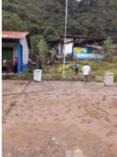
Fig 1. Afectación de la I.E 30682 y 668 CARLOS NORIEGA JIMENEZ
