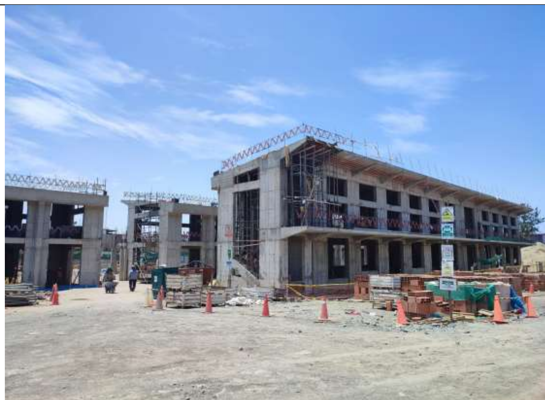
Pabellones en construcción
