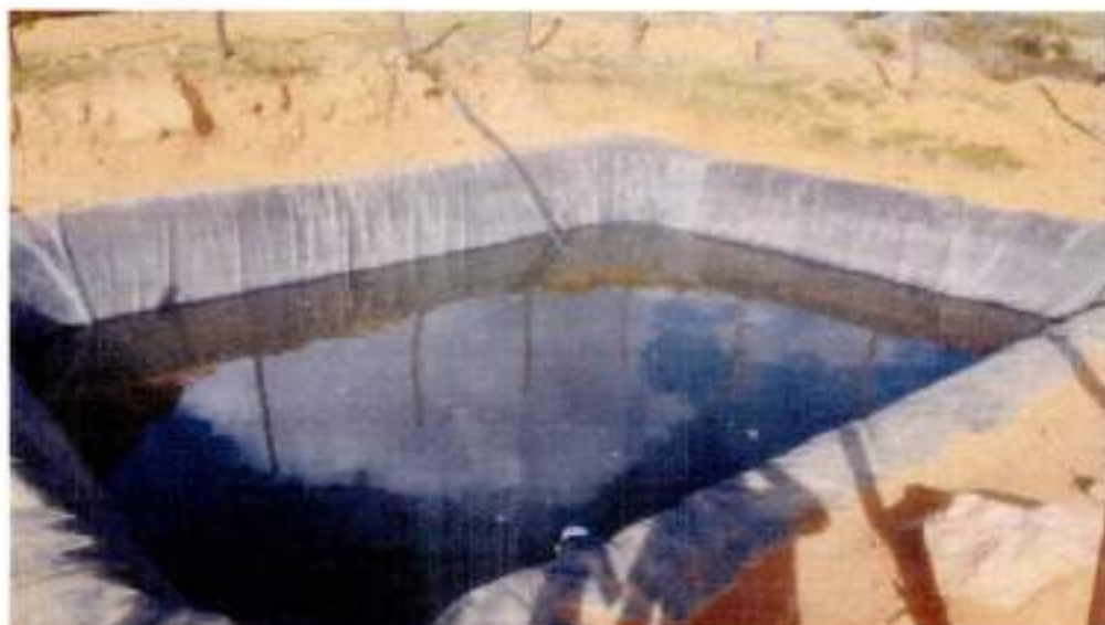
Reservorio Barrio Bolognesi operativo
