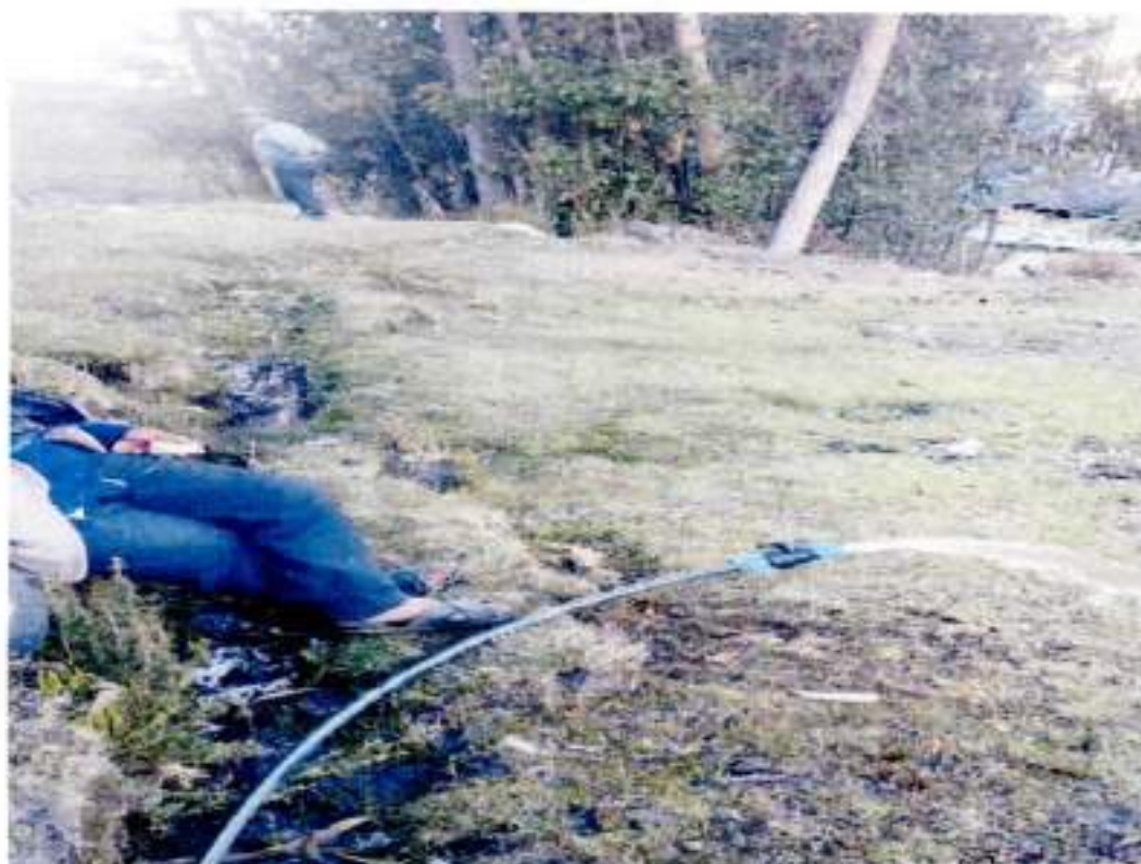
Realizando pruebas para instalar los aspersores
