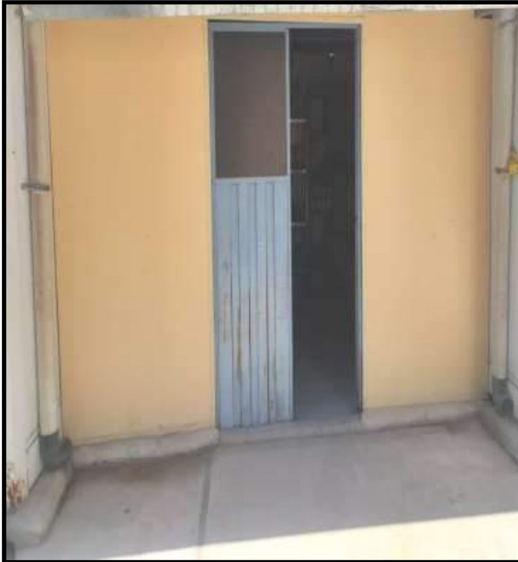
FOTO 01: AMBIENTE DE ALMACEN ACONDICIONADO
