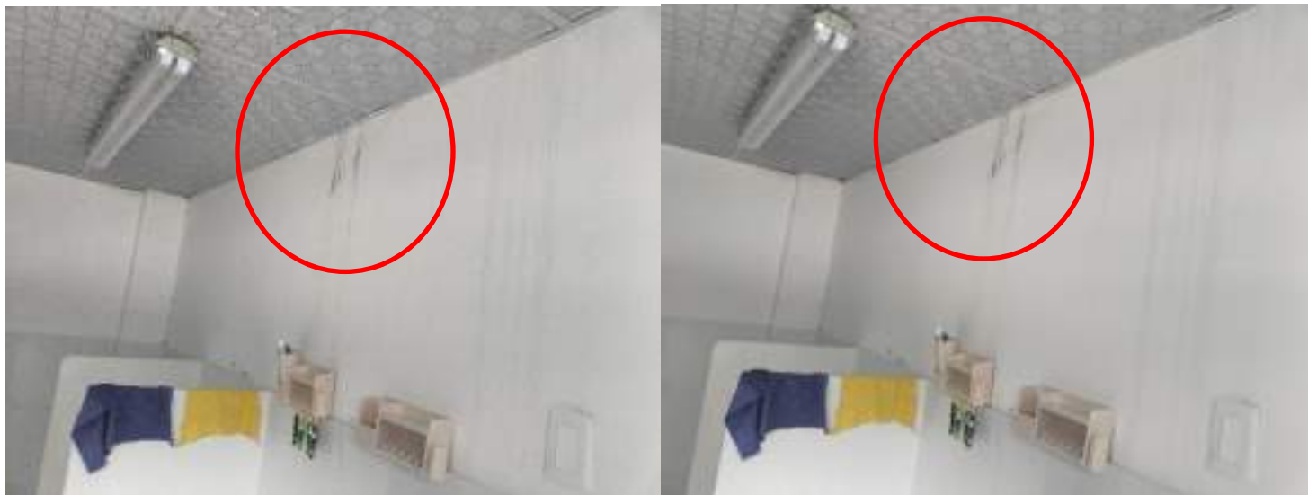
Fotografía de goteras en el interior de los baños de niños
