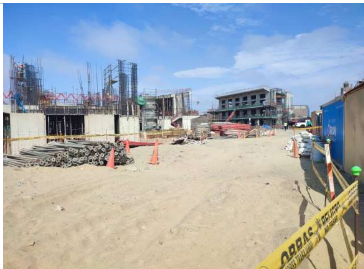
Ingreso a pabellones
