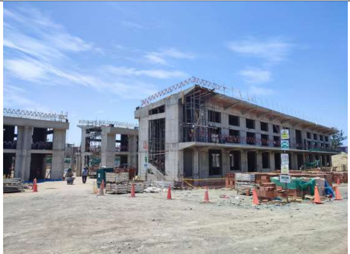
Pabellones en construcción
