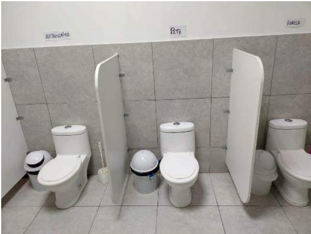
Anexo 6 -El baño para los niños/as guarda la debida privacidad
