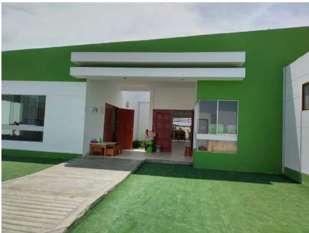
Anexo 5 – Ingreso al CIAI sin marcas en el piso que ayuden a guardar distanciamiento
