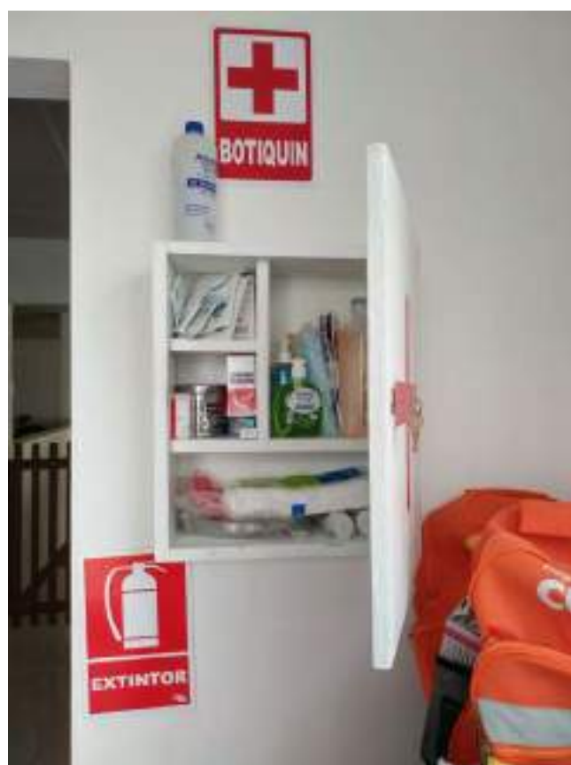
Anexo 7 – botiquín en el CIAI debidamente equipado, pendiente la evaluación de empotrar el extintor
