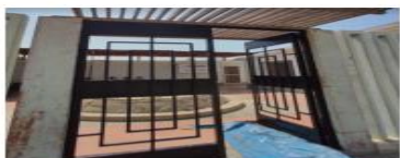
PUERTA DE INGRESO CON INTERVENCIÓN POR PARTE DEL CONTRATISTA.
