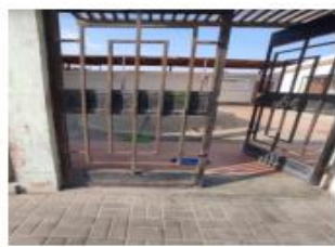
PUERTA DE INGRESO ANTES DE INTERVENIR
