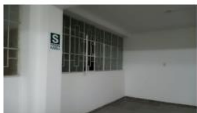
PINTADO DE MUROS INTERIORES
