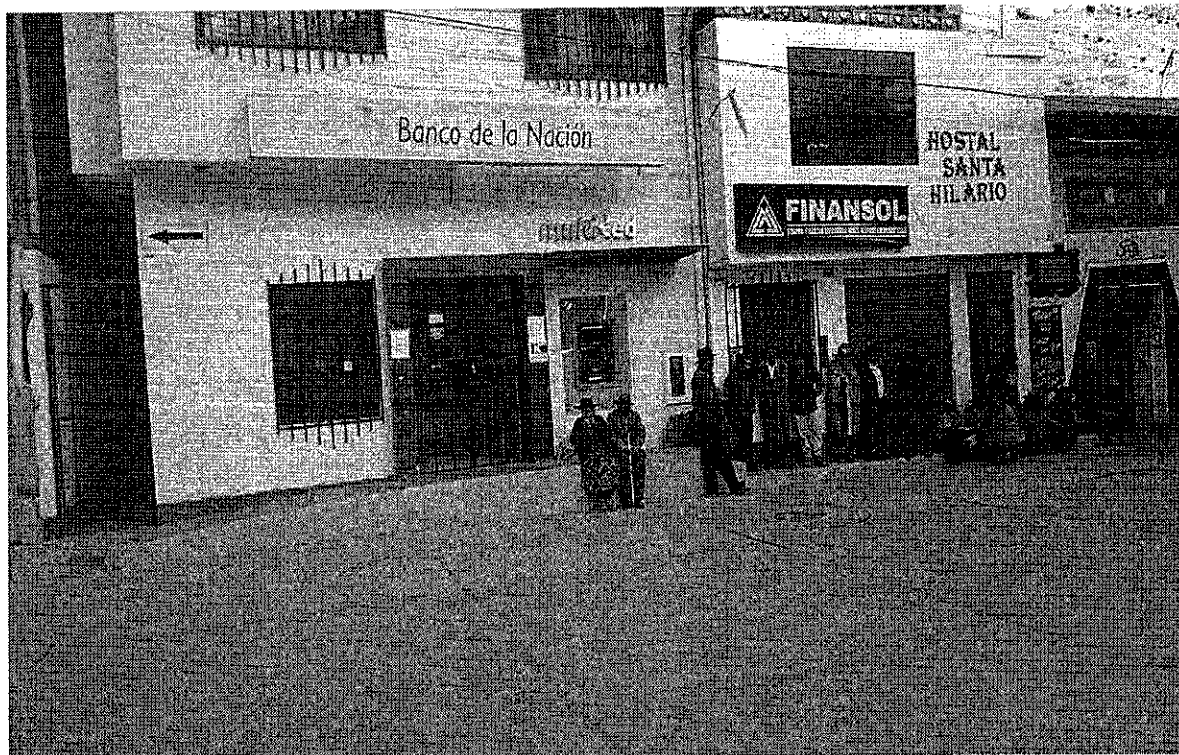
Foto 01: Punto de pago no tiene rampas con barandas para que puedan movilizarse los adultos mayores.
