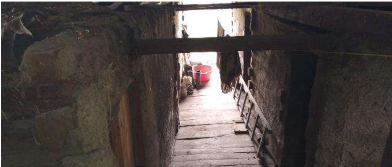
Anexo 10: Fotografía del pasadizo del segundo piso de la casa de la Sra. Maximina Valle de Catpo
